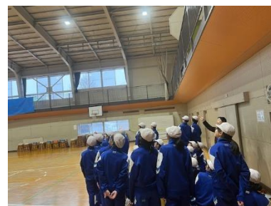
【体育館のLED照明】
